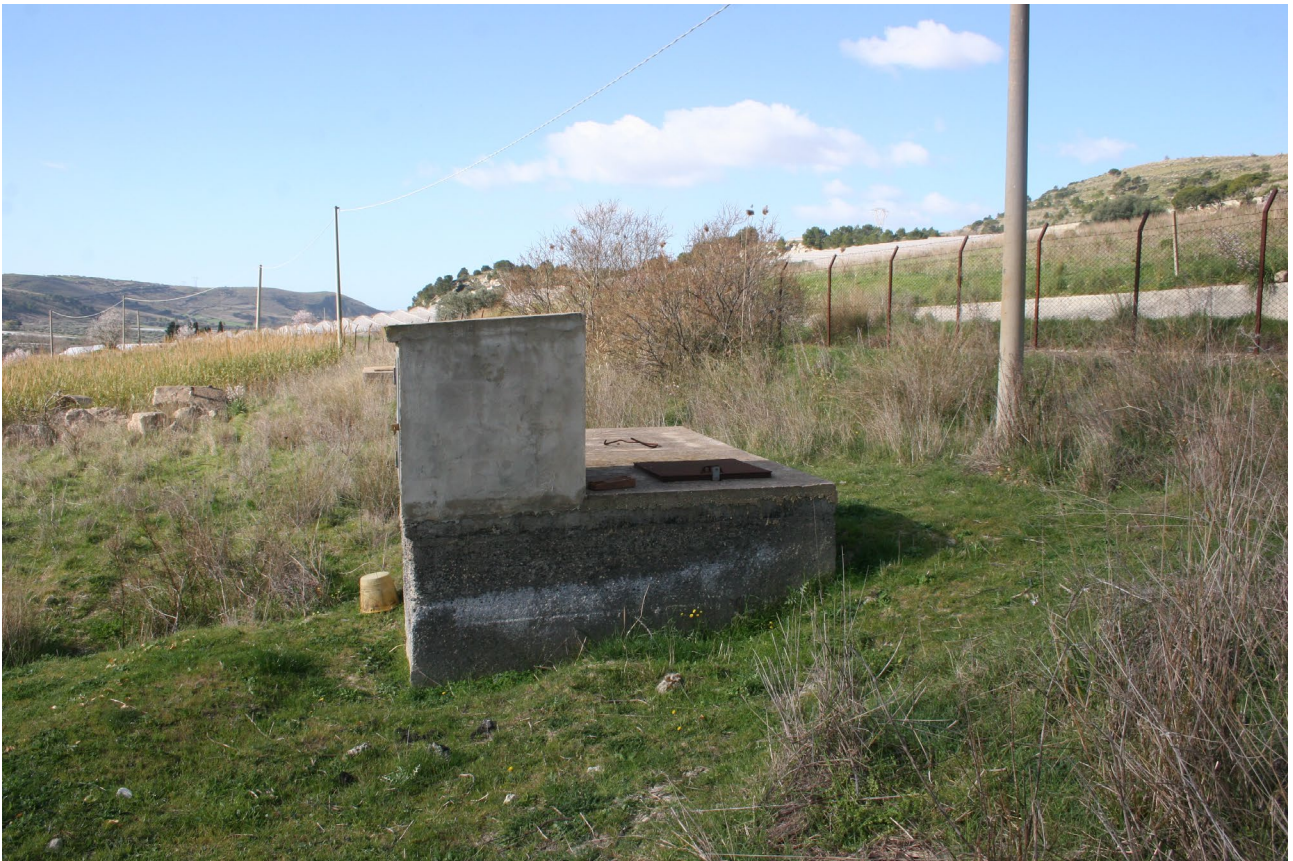
Vasca di disconnessione Zero - Camera di manovra 1
