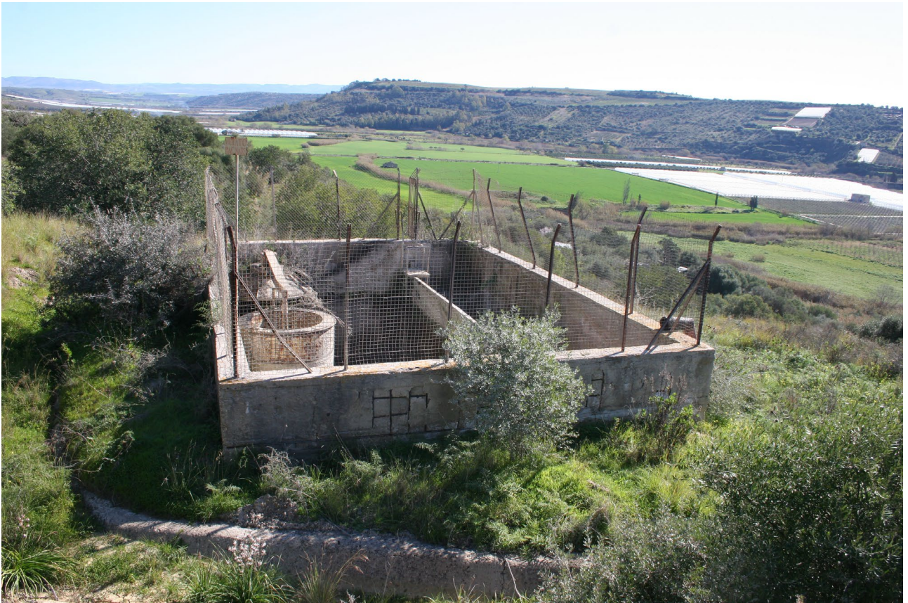
Vasca di disconnessione 4
