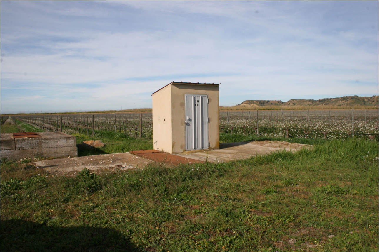
Camera di manovra presa n. 18
