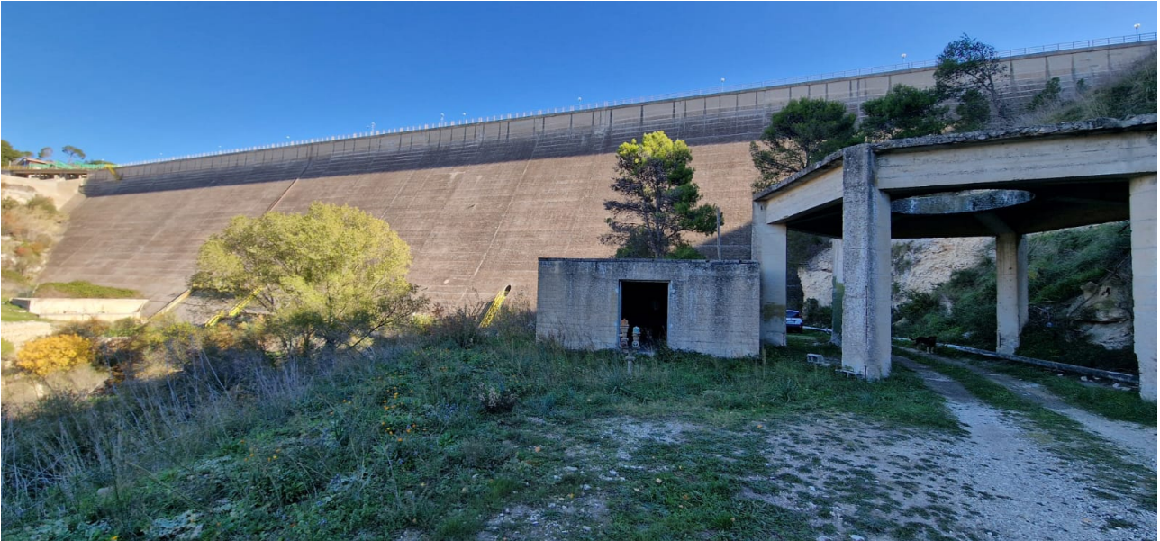
Camera di manovra presa diga Ragoletto - Foto n. 1
