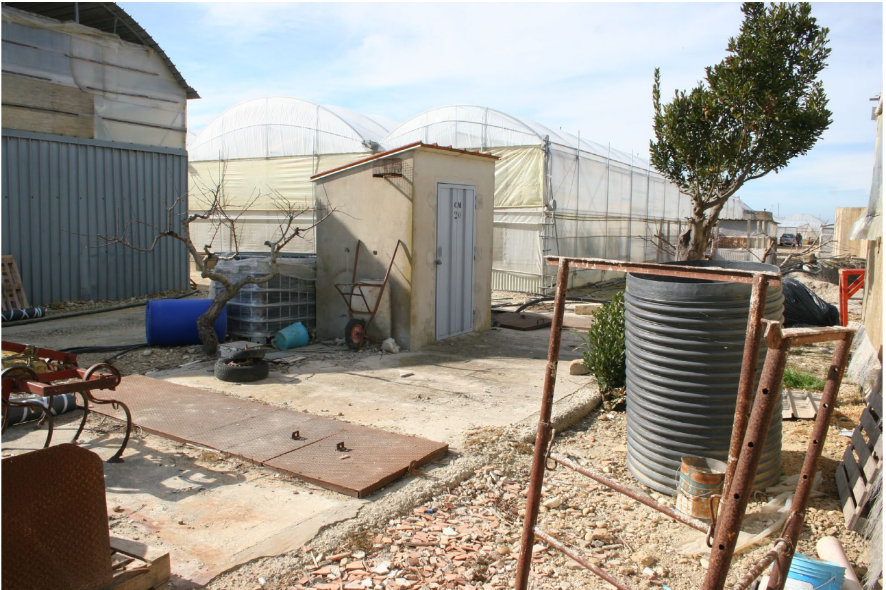
Camera di manovra presa n. 19-19-bis-20
