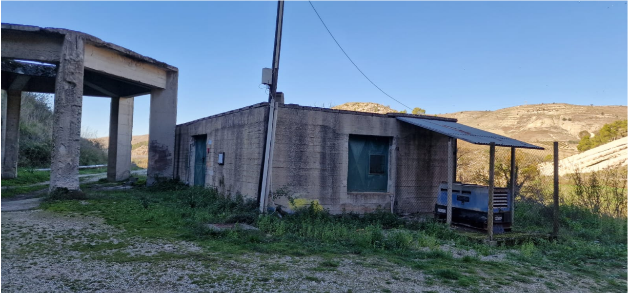
Camera di manovra presa diga Ragoletto - Foto n. 3
