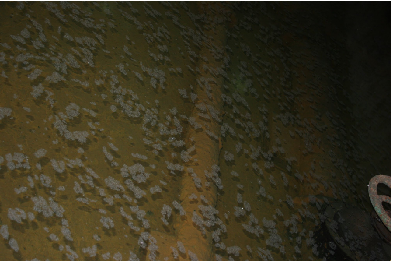
Camera di manovra presa n. 18
