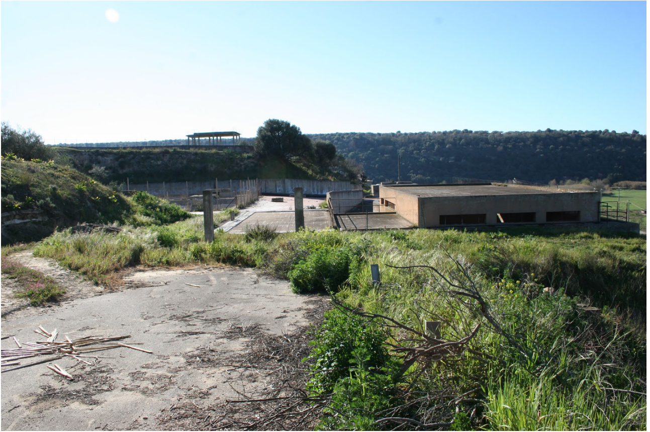
Vasca di disconnessione 3
