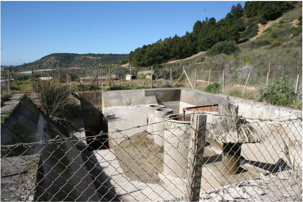
Vasca di disconnessione 5
